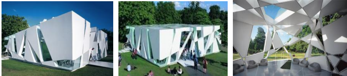
شكل ( 9 ) اتباع الاسلوب الخوارزمي في التصميم الداخلي والخارجي لجناح معرض سيربنتين 2002 Serpentine Gallery الذي صممه Toyo Ito and Cecil Balmond ويتضح الاستفادة من الخطوط المعمارية كنوافذ وفتحات للسقف ومعالجة التصميم الداخلي باعتبارها عنصر أساسي في التصميم . (www.serpentinegallery.org/architecture).
